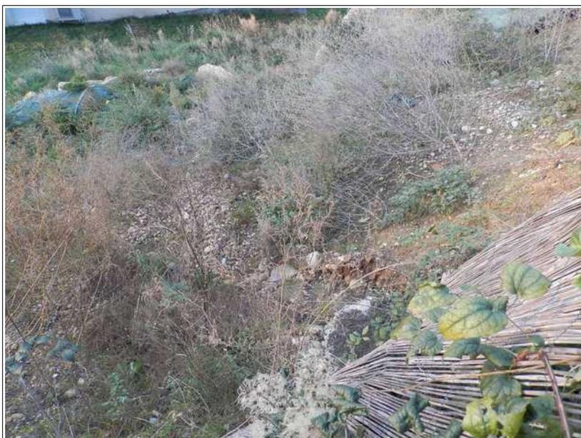
Gros plan sur la zone de glissement de terrain, on distingue les traces laissées par la venue d'eau (trace d'érosion). On notera la forte fraction graveleuse du terrain et sa matrice argileuse, caractéristiques des dépôts morainiques décrits par la carte géologique locale. A l'aval, l'enrochement « bousculé » est visible.
